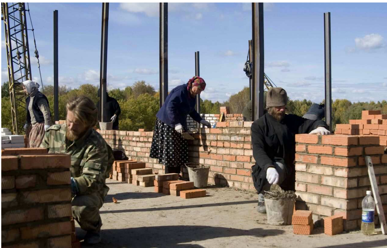
Мама в центре, на строительстве склада в Волоке.
